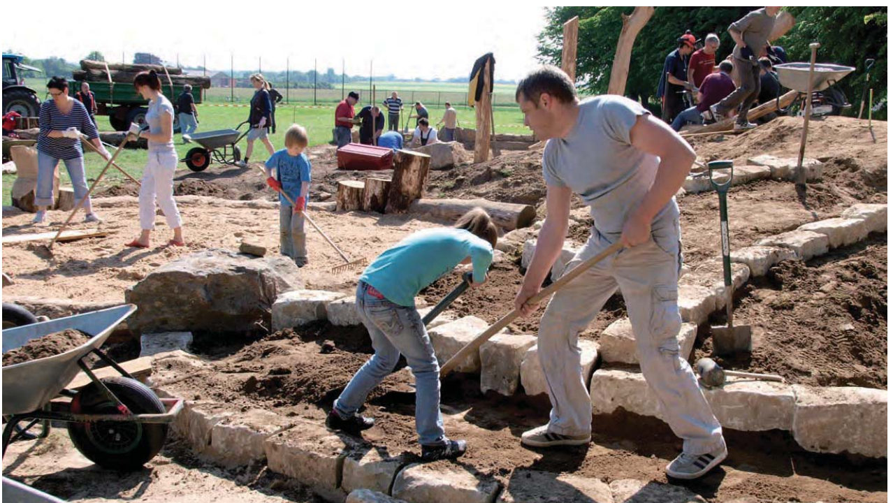
5 Impression einer Mitmach-Baustelle
